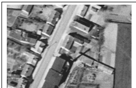
Figur 1 huset er nedrevet efter 1954
